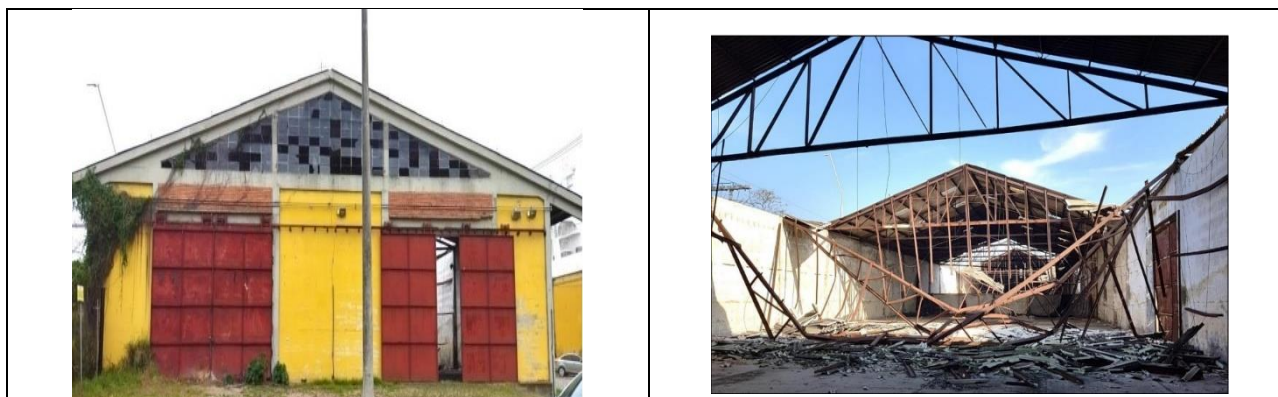
Figura 2: Situação Atual Armazém E1, POA11. Fonte: ENGEPE Engenharia
